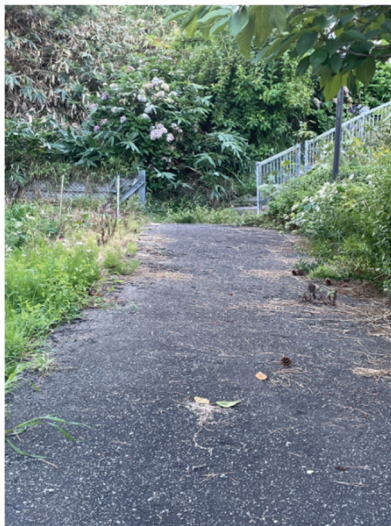
写真6 津波の避難経路(1) 道に雑草が繁茂しており、避難の際に 通りにくい状況となっている。
