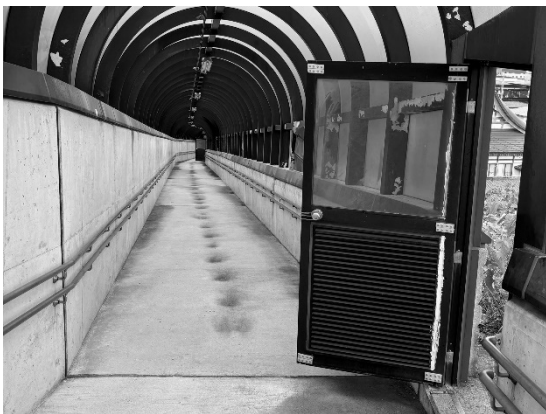
写真3 避難路の中 手すりと扉がある
