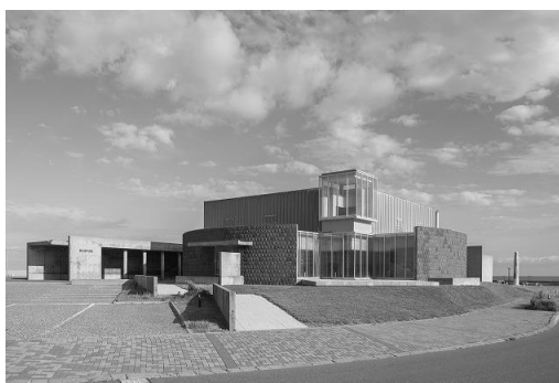
奥尻島津波館
