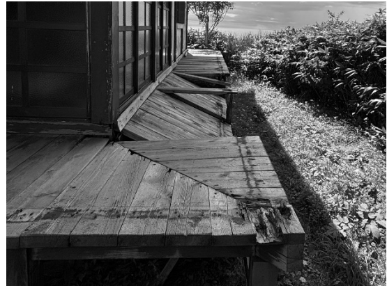
写真2 神社の抜け落ちた回廊
