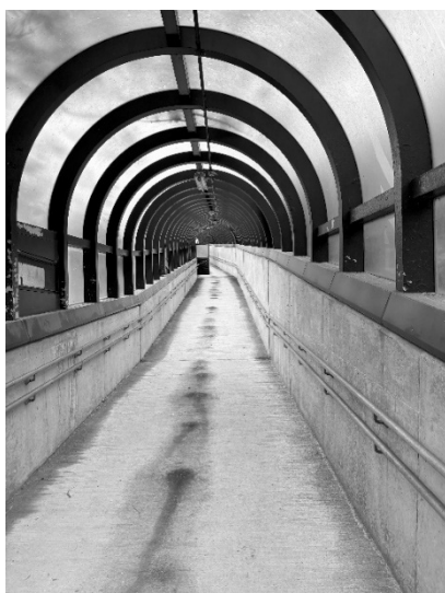
写真6 避難路内部の様子
