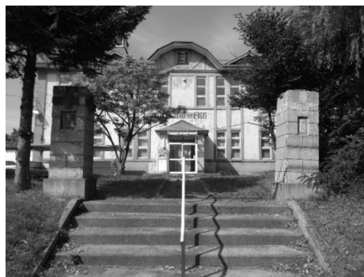
写真6 旧斜里町役場庁舎
