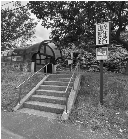
写真1 避難路の看板と外観
