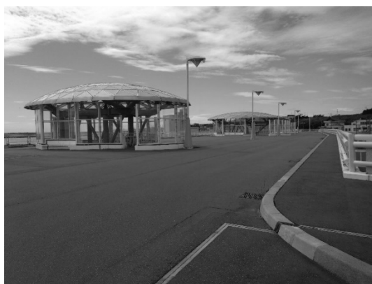
写真7 人工地盤「望海橋」
