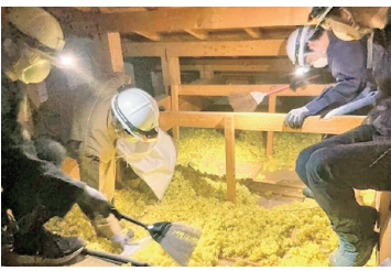
屋根裏の断熱材を撤去
