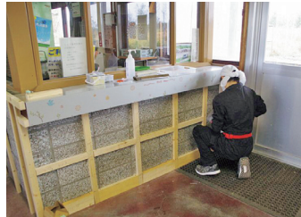
窓カウンターの腰壁下地組み
