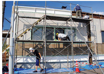
外部鉄骨に下地を塗装
