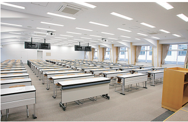
エアコンが設置された34番教室
