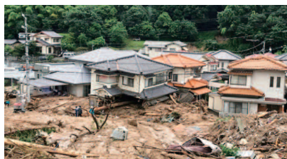
2018年7月 西日本豪雨土砂災害 広島県広島市 (提供: 防災システム研究所 山村武彦氏)
