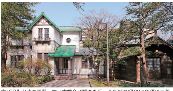
右が旧永山武四郎邸、左は木端会が調査を行った新棟で昭和12年頃に三菱鉱業セメント社員寮として付設された(札幌市中央区北2条東6丁目2番地)
