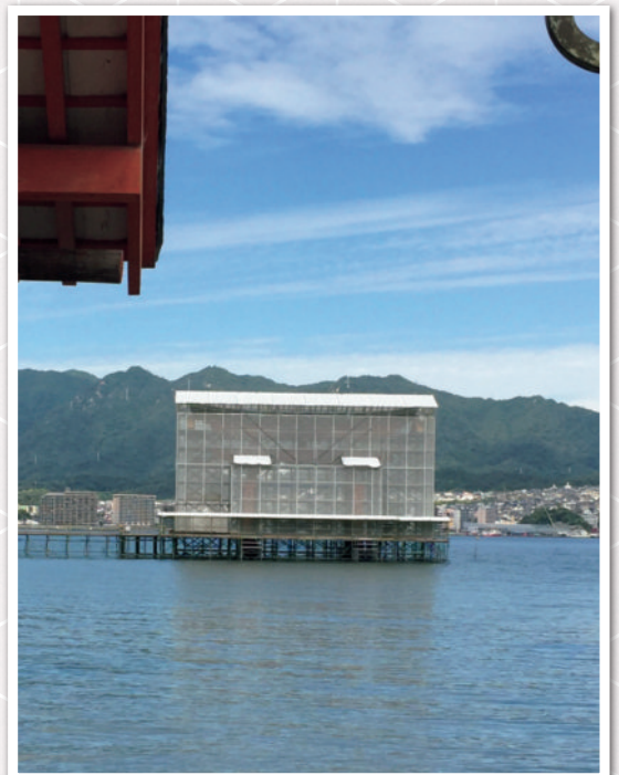
工事中の厳島神社大鳥居
